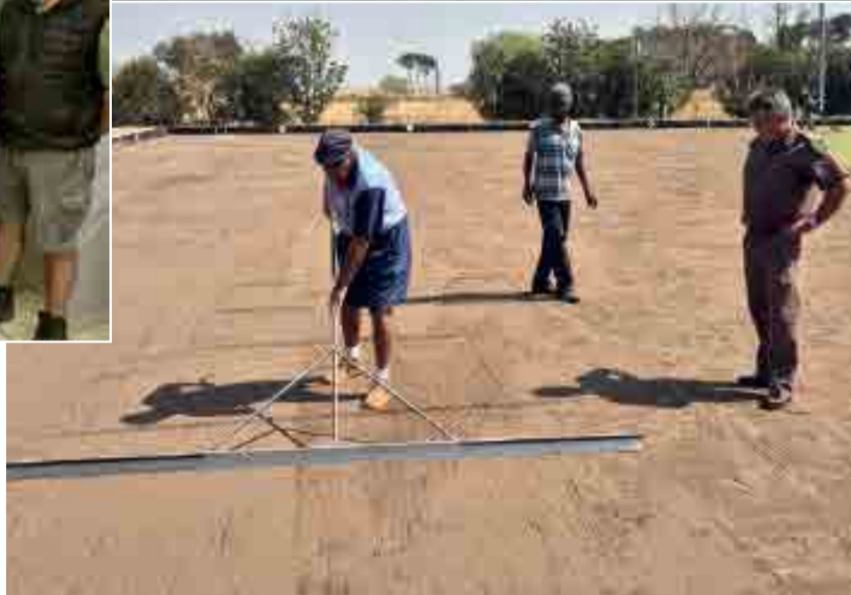
Op die foto word die grondlaag gegooi en gelyk gemaak. Die baan is behandel met onkruid- en insekdoder. Die grondlaag bestaan uit gesterileerde mis, swart en wit silica en fyn turf. Kunsmis is in twee lae toegedien. Op die foto is Bertus besig om die bolaag gelyk te maak.
